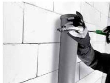
fot. 23 W ostatniej fazie montażu wprowadzamy do obejmy rurę lub kształtkę i łączymy ze sobą dwie części otwartej obejmy.
