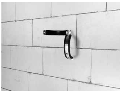
fot. 22 Otwarta obejma w pozycji do montażu rurociągu.
