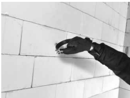
fot. 21 Po osadzeniu w ścianie kołka rozporowego przystępujemy do montażu obejmy wkręcając ją ruchem obrotowym do ściany.
