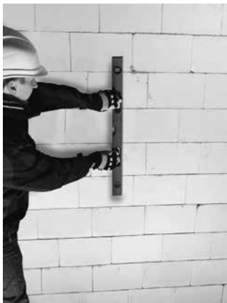
fot. 18 Za pomocą poziomicy wyznaczamy linię przebiegu pionu kanalizacyjnego AMAXPRO.
